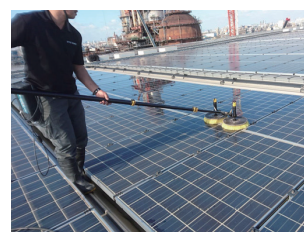
太陽電池モジュールの洗浄
