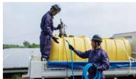
③給水車から使用水を送り、積載車両に搭載されている純水器を経由させ、洗浄機に純水を送水
