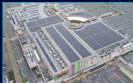
設備容量: 676.80kW (発電出力・モジュールベース: 860.11kW)
