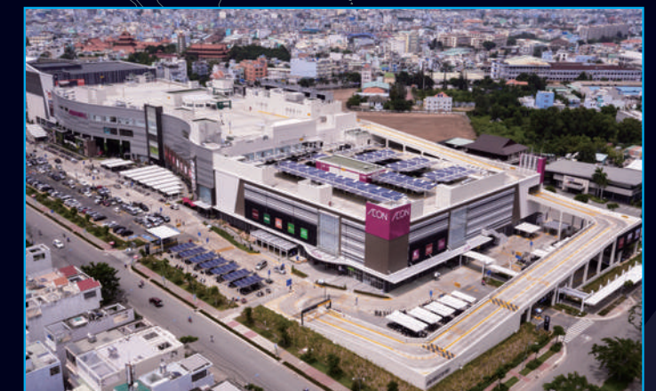
設備容量: 320.00kW
