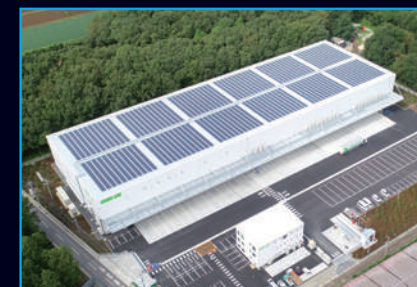
設備容量: 744.15kW
