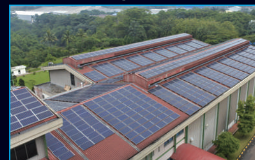
設備容量: 500.00kW
