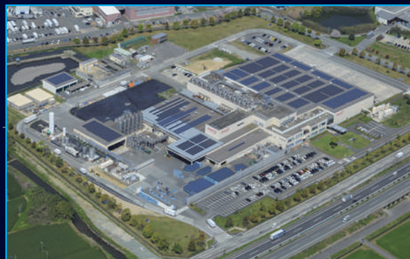
設備容量: 2367.02kW (PCS出力1755.70kW)
