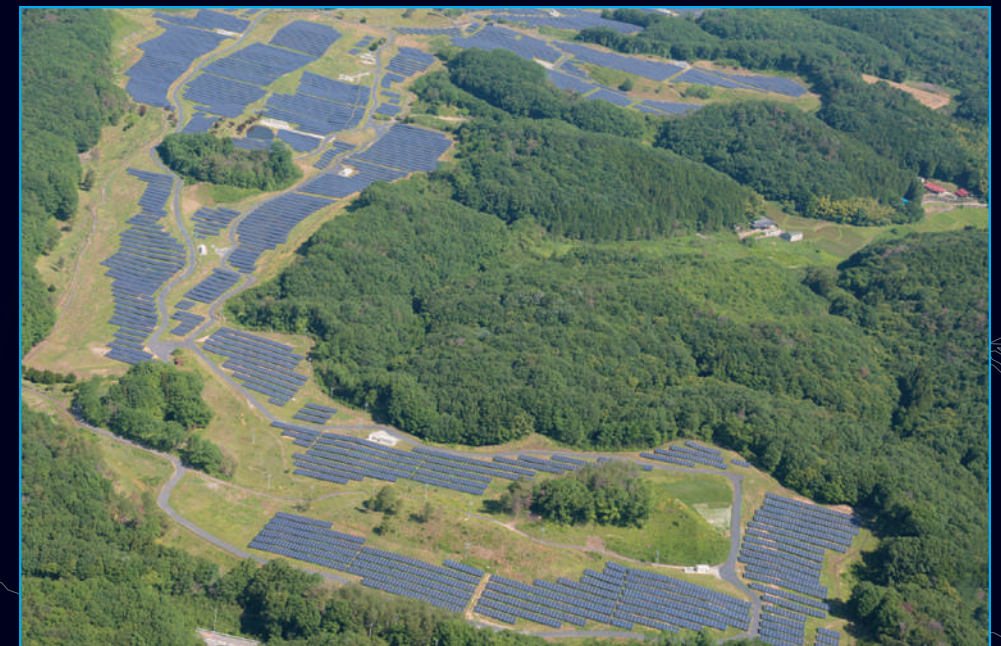
設備容量: 2367.02kW (PCS出力1755.70kW)
