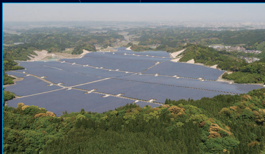
設備容量: 40.36MW
