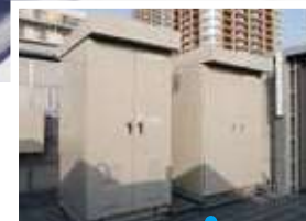
マルチパワーコンディショナ、蓄電池設置
